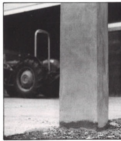
Håndreparation af brandskadedet betonsøjle. Den skadede beton borthugges, og overfladen fremstår med sund beton. Armeringsjernet behandles med korrosionsbeskyttende materiale. Overfladen indkastes med svummemørtel, og søjlen pudses op. Derefter afdækkes reparationsområdet mod udtørring, og betonsøjlen er færdigrepareret.
