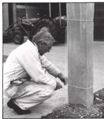
Håndreparation af brandskadedet betonsøjle. Den skadede beton borthugges, og overfladen fremstår med sund beton. Armeringsjernet behandles med korrosionsbeskyttende materiale. Overfladen indkastes med svummemørtel, og søjlen pudses op. Derefter afdækkes reparationsområdet mod udtørring, og betonsøjlen er færdigrepareret.
