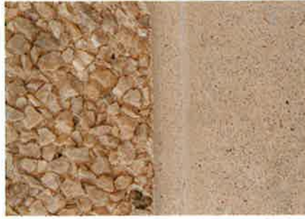
Frilagt og afsyret overflade med lysit.
