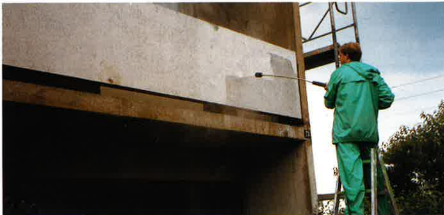
16 Afrensning af brystningselement med rent vand under højt tryk.
