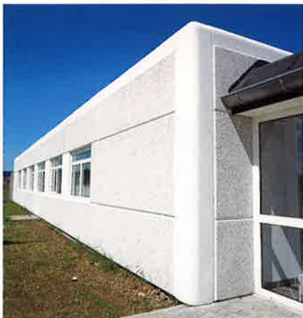
Frilagte, hvide facadeelementer med glatstøbte, afrundede hjørner.
