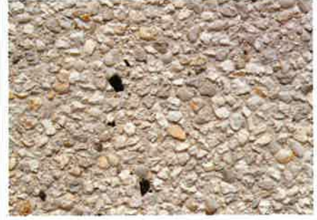
Hvid beton med frilagt calcineret flint.
