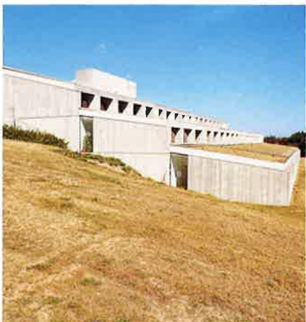
Pladsstøbt beton med ubearbejdet overflade.
