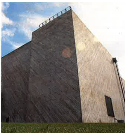
Pladsstøbt betonbyggeri med ubearbejdet overflade. Tekstur fra skrå bræddeforskalling.
