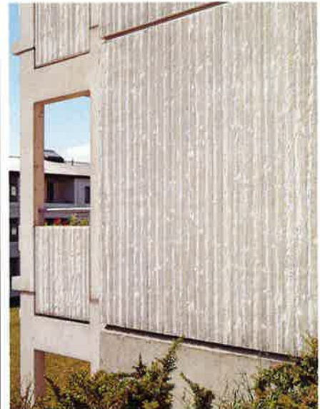
Facadeelement med tekstur fra træforskalling påført via gummimatrice.
