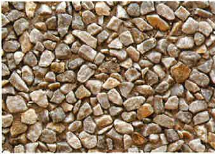
Frilagt overflade med Hardeberga granit.
