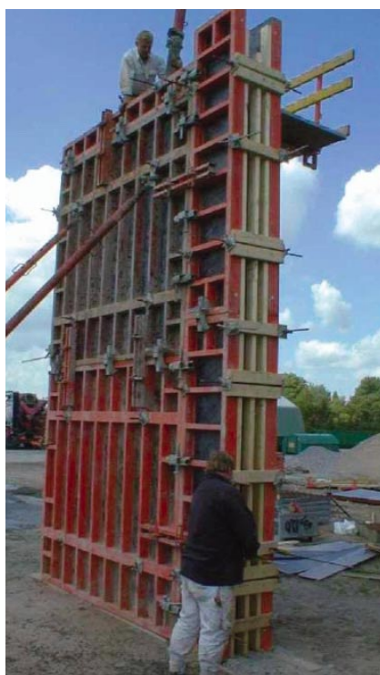
Figur 24. SCC pumpes i høj form med pumpe studs neddykket i betonen.
