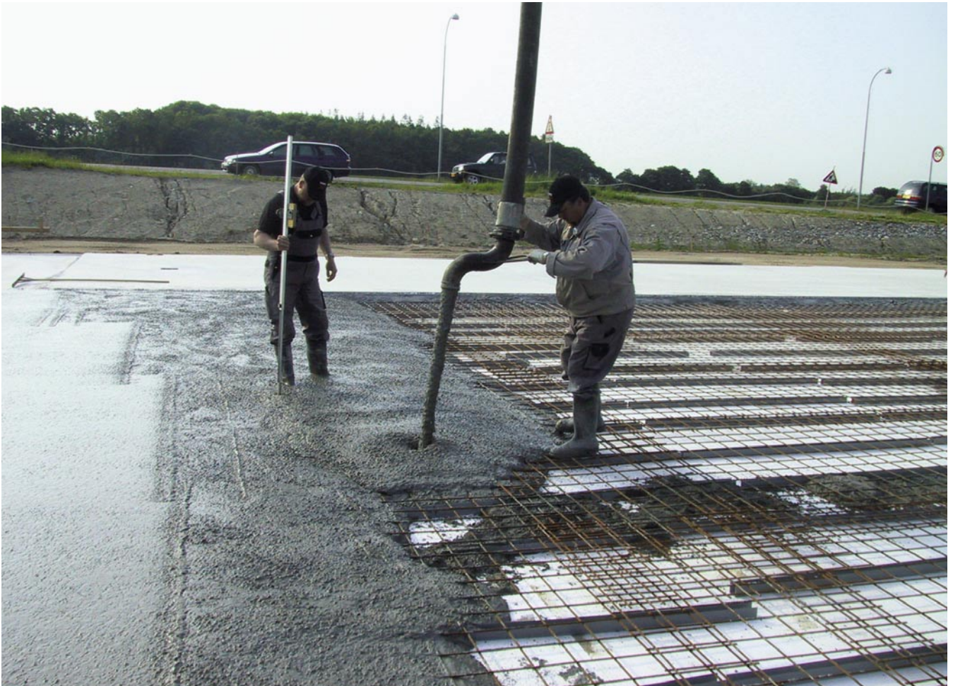
Figur 16. Udlægning af SCC med opbygget støbefront.
