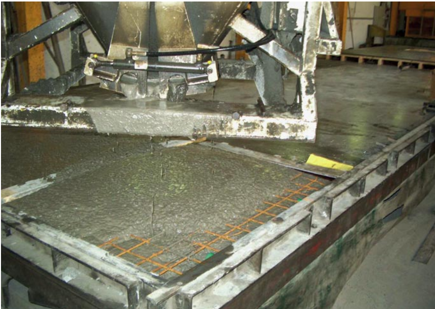
Figur 19. Vandret udstøbning af betonelement.
