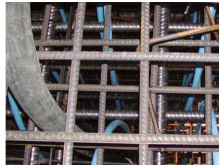
Figur 21. SCC er særlig egnet til komplicerede støbninger, hvor det er svært at få vibreret traditionel beton ordentligt.
