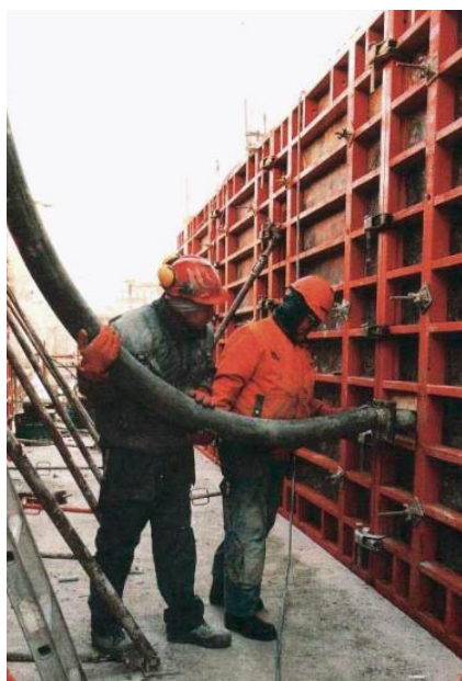
Figur 23. SCC pumpes ind i den nederste del af formen.
