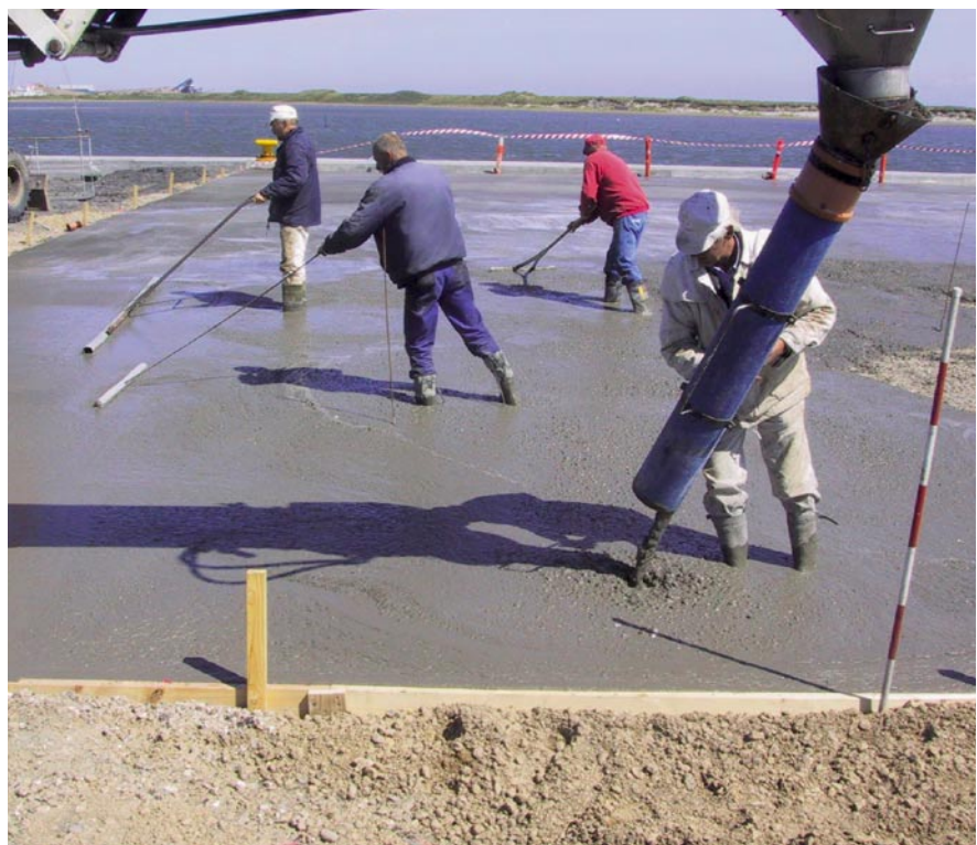
Figur 15. SCC øger produktiviteten ved store gulvstøbninger.
