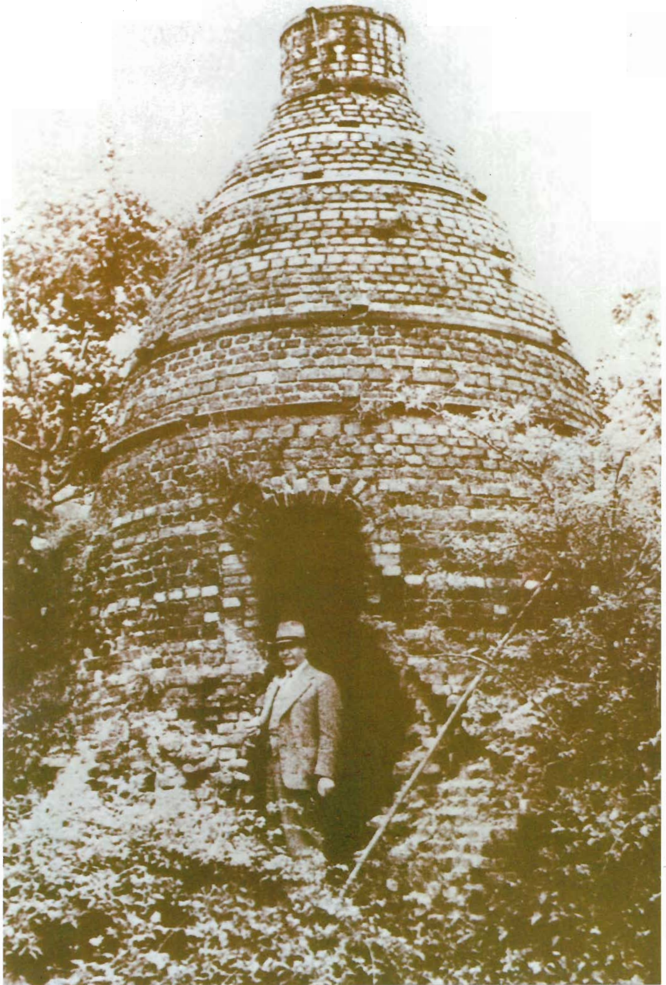
2 Figur 1. Den første skaktovn for brænding til portlandklinker, anvendt af portlandcementens opfinder, Joseph Aspdin, i midten af forrige århundrede.
